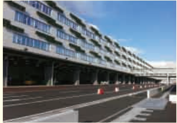
羽田営業所が入居する東京国際エアカーゴターミナル第一国際貨物ビル
