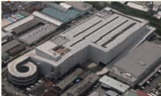
三郷ロジスティックセンター 所在地:埼玉県草加市 延床面積:約21,700坪(4階建)/完成:平成20年4月
