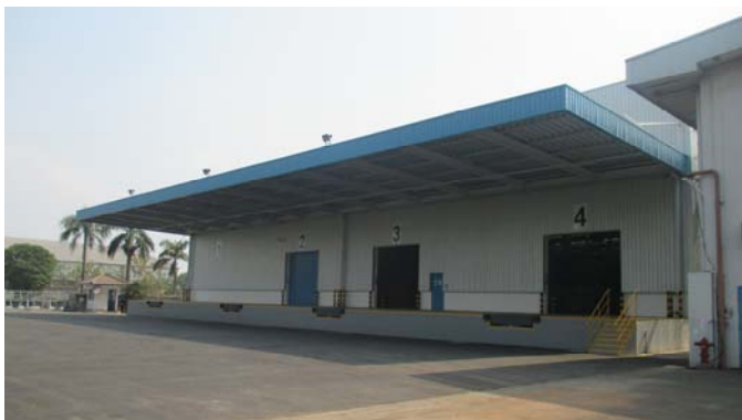
物流センター増築部分
