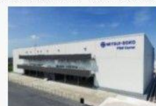
■建設イメージ 関東P&Mセンター既存A棟外観
