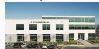
■ Los Angeles拠点外観
