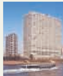
三井倉庫箱崎ビル
