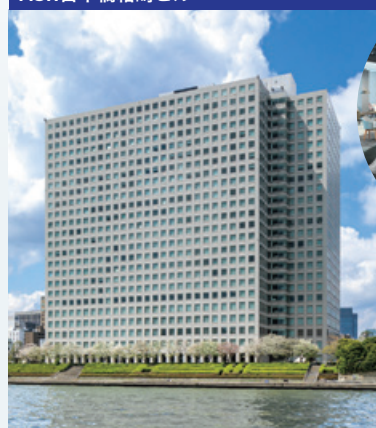
MSH日本橋箱崎ビル
