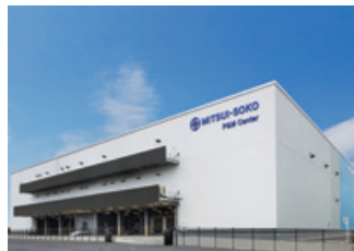
関東P&Mセンター（埼玉県加須市） 2015年9月竣工 延床面積約6,000坪
