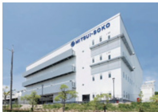
関西P&Mセンター（兵庫県神戸市） 2015年5月竣工 延床面積約4,000坪
