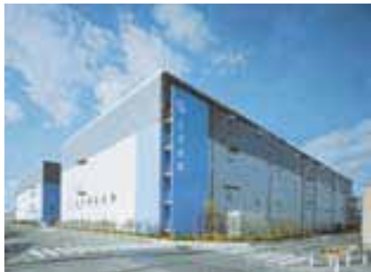
■ 北大阪倉庫 大阪府摂津市(2005年12月完成)
