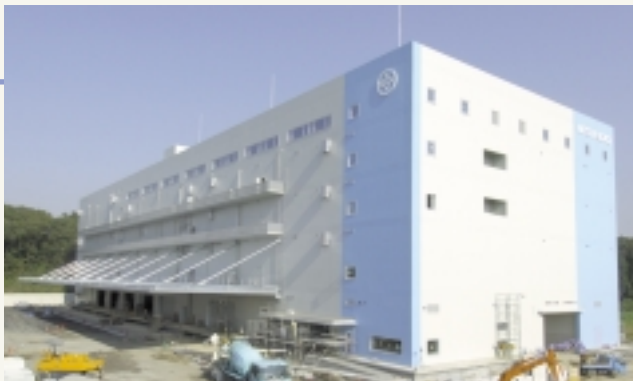
完成間近の三井倉庫レコードセンター
