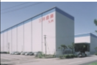
三井倉庫九州(株) 福岡・箱崎埠頭自動化倉庫
